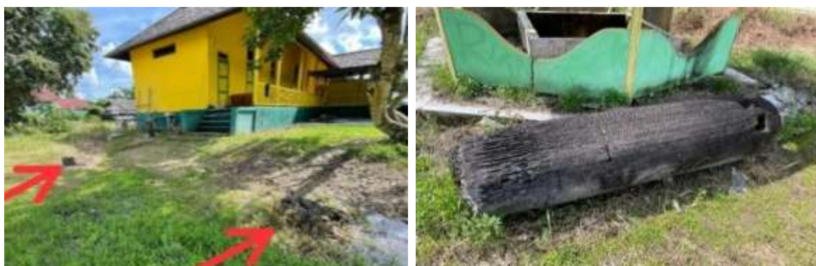
Gambar 6. Sisa tiang pondasi istana kedua di halaman belakang istana Sumber: Dokumentasi pribadi (2025)
