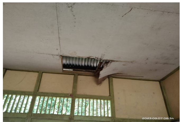
Gambar 2. Atap ruang kelas 5 SDN 50 Kayu Tunu
