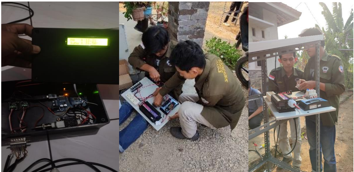
Gambar 4. Kegiatan instalasi alat sensor suhu dan pH air pada kolam ikan menggunakan solar panel
