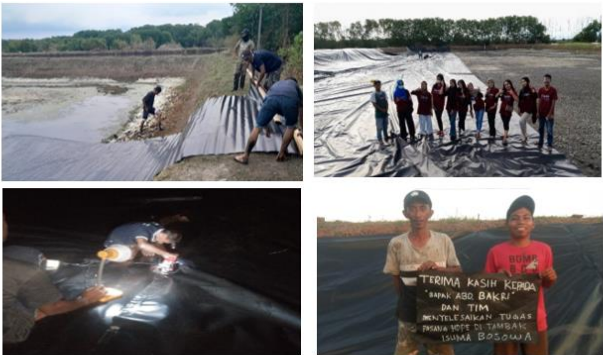
Gambar 2. Pemasangan Terpal HDPE
